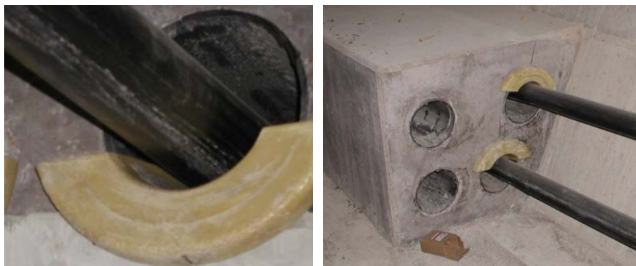
Rys.10. Przykład zastosowania dewiatorów systemu SUSPA Drut Ex.
