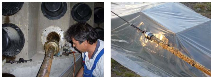
Rys.11. Operacja wymiany kabla sprężającego typu SUSPA-Drut Ex.
