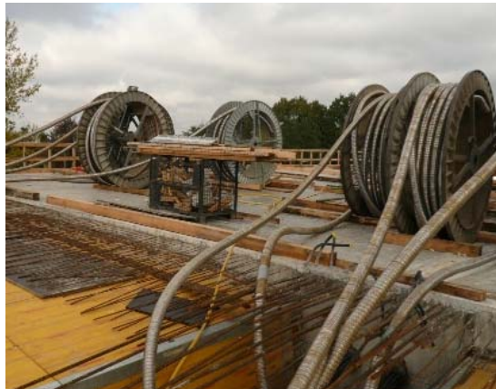
Rys.7. Przygotowanie kabli do przesunięcia rusztowań na kolejnych odcinkach budowlanych. Autostradowa Obwodnica Wrocławia, obiekt WA20.
