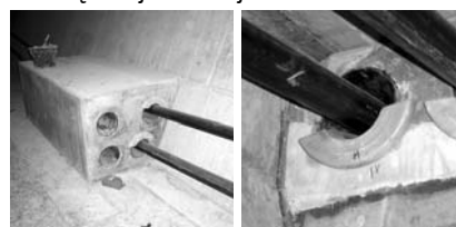
Fot. 5. Przykład zastosowania dewiatorów systemu SUSPA Drut Ex
