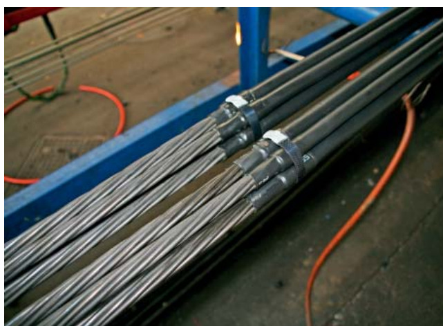
Fot. 5. Przykład zabezpieczenia strefy przejściowej za pomocą taśmy termokurczliwej oraz prawidłowej stabilizacji splotów
