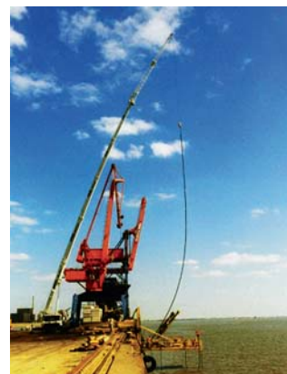
Fot. 2. Zastosowanie kotew gruntowych na kanale Brünsbutel/Niemcy
