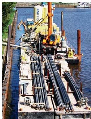
Fot. 1. Zastosowanie kotew gruntowych na kanale Oldenburg/Niemcy
