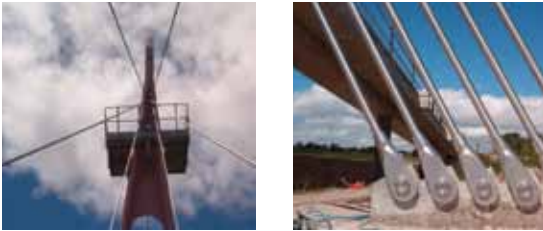
Szczegóły Mostu Watergrass - Irlandia
